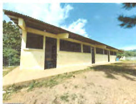
Foto 4: Preparación de la superficie y aplicación de pintura a dos manos, en paredes interiores y exteriores del establecimiento.
