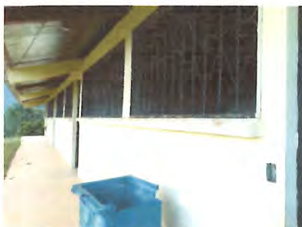
Foto 3: Sustitución de ventanas; sistema de apertura: Corredizas, Perfiles color blanco estandar, Material del marco: PVC Material de la ventana: Vidrio, sellado perimetral.
