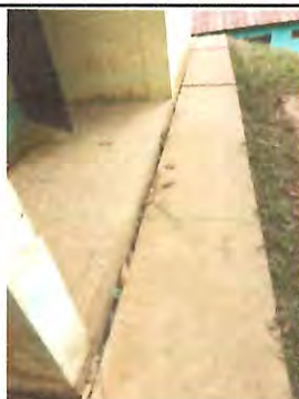
Foto 5: Reparación de losa de concreto para patios, armado, nivelación y acabado rustico a un costado de los sanitarios, reparación de gradas al ingreso a establecimiento y en área de la galera
